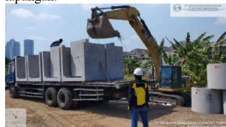
Gambar 2. Pengadaan U-Ditch 150.150.120 FC'30 MPa dan U-Gutter dan Cover Pelaluan Air 30.20.60 FC'30 MPa Sumber: Dokumentasi Lapangan
