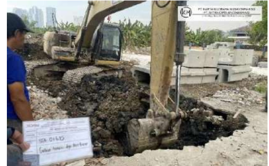
Gambar 2. Galian Tanah Untuk DUB Sumber: Dokumentasi Lapangan
