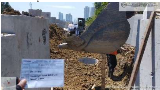
Gambar 1. Pemasangan Cerucuk Dolken Sumber: Dokumentasi Lapangan
