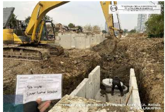
Gambar 8. Pemasangan Buis Beton 100x100x10 Sumber: Dokumentasi Lapangan
