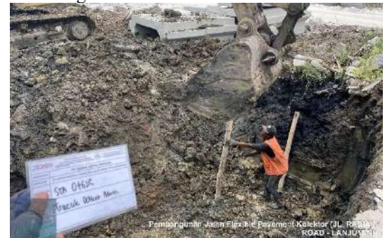
Gambar 3. Pemasangan Cerucuk Dolken Sumber: Dokumentasi Lapangan
