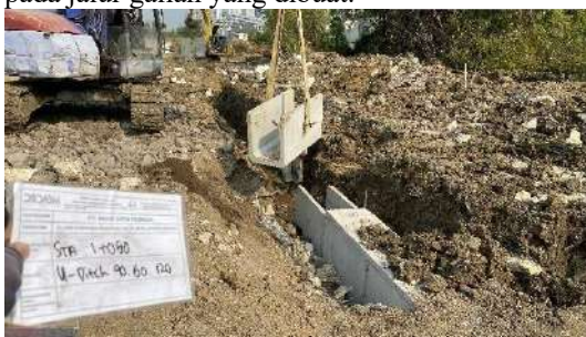
Gambar 6. Pemasangan U-Ditch 40x60x120 cm fc'30 MPa Sumber: Dokumentasi Lapangan
