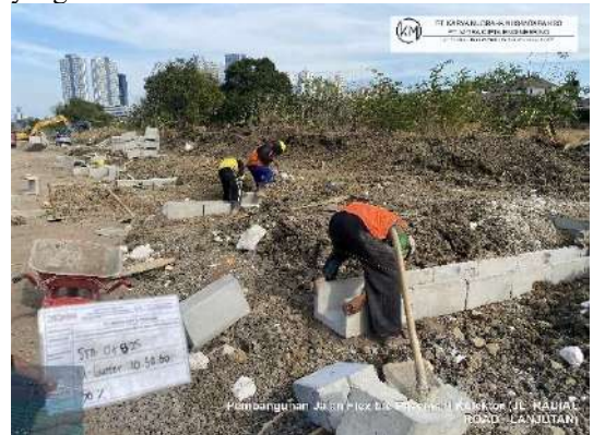
Gambar 7. Pemasangan u-gutter dan cover tipe 30x20x60 cm fc'30 MPa Sumber: Dokumentasi Lapangan
