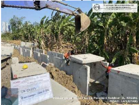
Gambar 5. Pemasangan U-Ditch dan Cover 150x150x120 cm fc'0 MPa Sumber: Dokumentasi Lapangan
