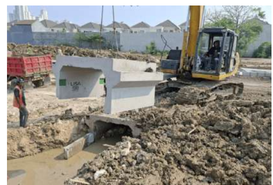
Gambar 4. Pemasangan Double U-Ditch Box 150x150x120 cm fc'30 MPa Sumber: Dokumentasi Pribadi
