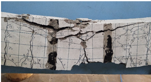
Gambar 15. Keruntuhan Balok BL 28 Sumber: Dokumentasi Pribadi
