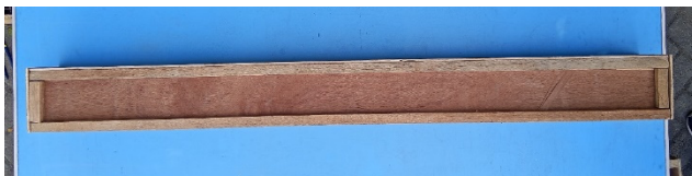
Gambar 4. Bekisting Balok Sumber: Dokumentasi Pribadi
