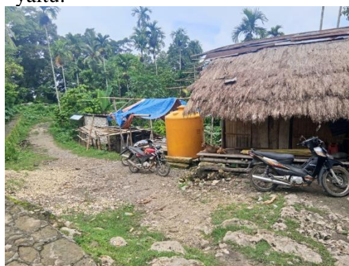
Gambar 5 Fasilitas Kamar Mandi Swadaya di Kampung Adat Kambajawa
