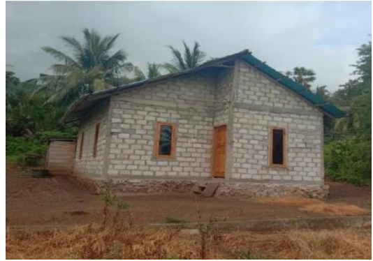
Gambar 3. Rumah untuk Keluarga Kurang Mampu di Desa Lelang (Sumber : Dokumentasi Desa Lelang, 2021)
